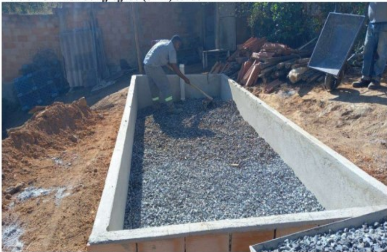
Foto 6 - Camada de agregado (brita) sendo finalizada na TEVAP.
