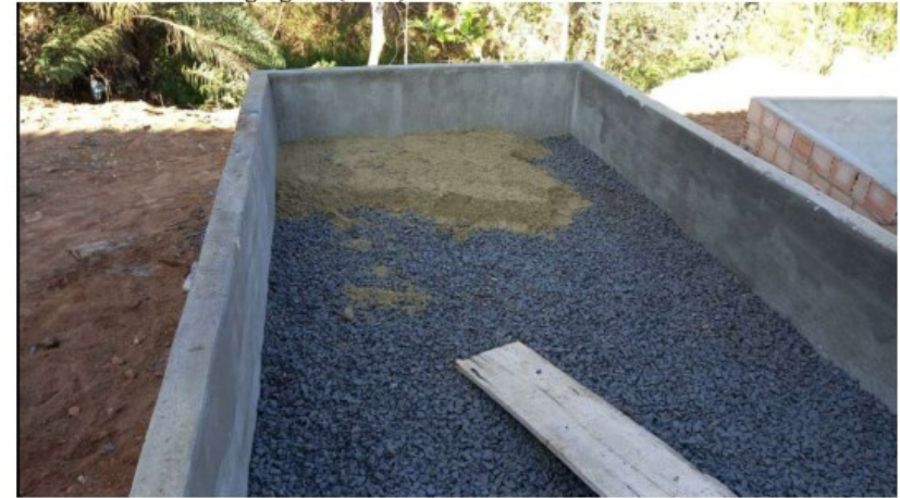
Foto 7 - Camada de agregado (areia) sendo colocada na TEVAP
