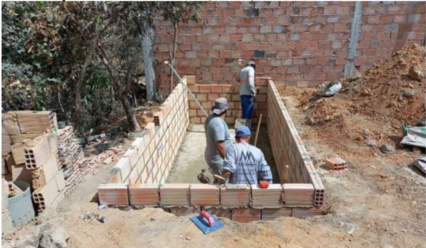
Foto 2 - Etapa construtiva da Alvenaria (TEVAP).
