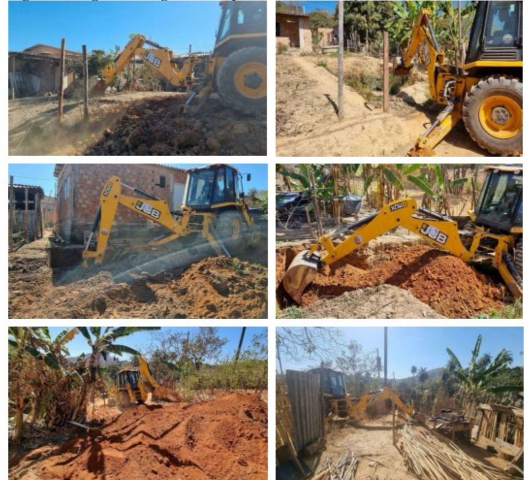
Figura 3 - Registros fotográficos de processos de escavação das TEVAPS
