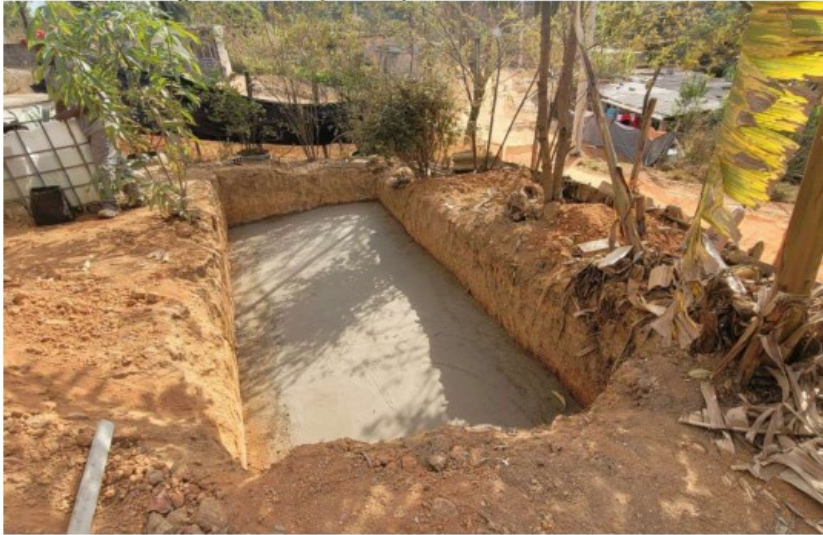
Foto 1 - Concretagem de fundo (TEVAP) na casa do sr. Mozart.
