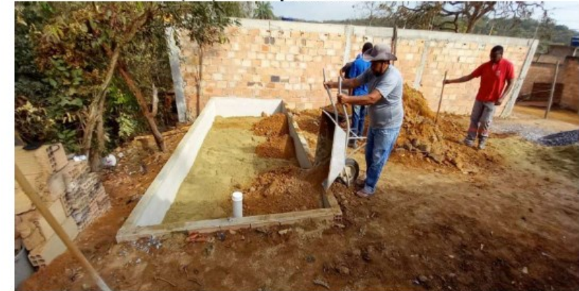
Foto 8 - Última camada (solo) sendo depositada na TEVAP.
