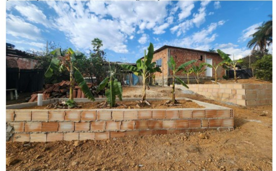
Foto 11 - Plantio de bananeiras finalizando a TEVAP da casa do “Maranhão” em primeiro plano e da dona Rosilene em segundo plano.
