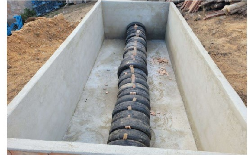
Foto 4 - TEVAP já rebocada e com a câmara de pneus já instalada.
