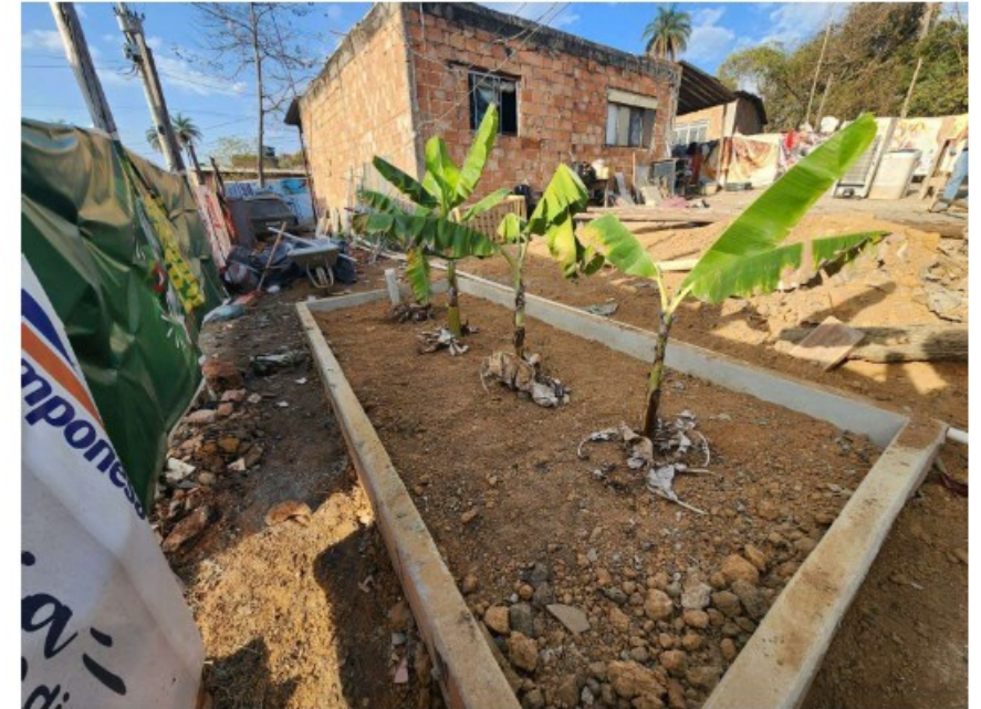
Foto 12 - Plantio de bananeiras finalizando a TEVAP da casa do Paulinha.
