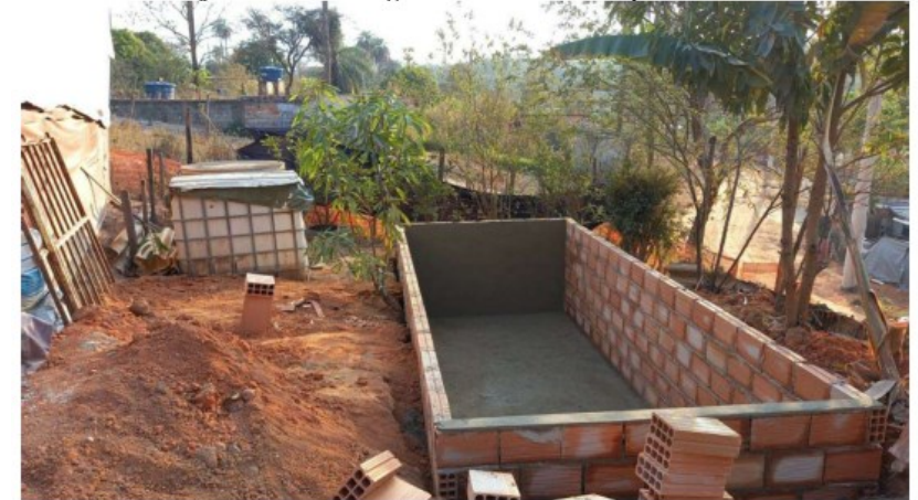
Foto 3 - TEVAP já com a concretagem de fundo e reboco parcial.
